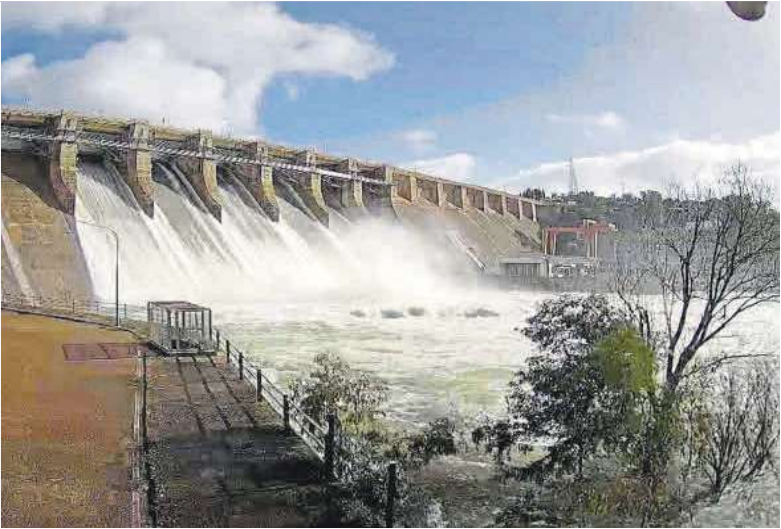
La presa del Zújar abrió ayer una nueva compuerta, aumentando el caudal hasta los 400 metros cúbicos por segundo.
