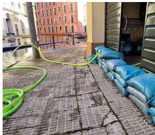
Los sacos de tierra siguen colocados frente a las puertas de los garajes. / L.G.C.
